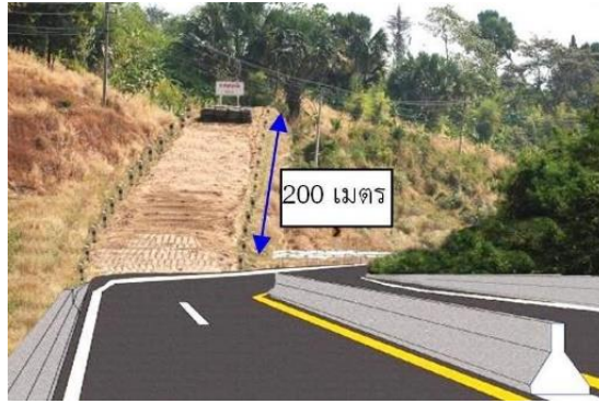
รูปที่ 2.2.1-6 ช่องทางหยุดรถฉุกเฉิน หลังทำการปรับปรุง
